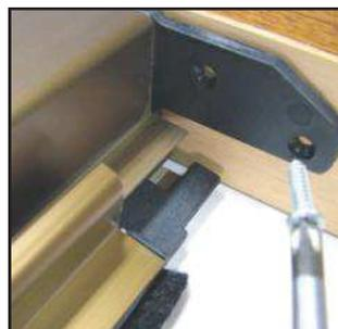
Prendere il cassonetto superiore ( n.1) e fissarlo con idonee viti alle spallette del muro per mezzo delle testate laterali (n.3)
