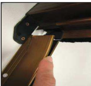
Infilare le guide laterali nell'invito del cassonetto e se necessario stringere leggermente l'invito superiore per infilare correttamente le stesse . Posizionare le guide verticalmente , premerle verso il basso , e fissarle al muro .
