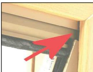
Prendere le guide laterali ( 4 ) sulle quali sono gia' inseriti di serie gli agganci inferiori della barra maniglia , verificare quale e' destra o sinistra ed inserirle a lato , facendo attenzione nella parte in alto , a far entrare la parte esterna della guida **DENTRO** il labbro inferiore del cassonetto come da foto .
