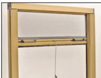
Aprire la zanzariera per mezzo del cordino ( n.2 ) , verificare che non ci siano impedimenti alla scorrevolezza della barramangia dovuti alle viti di fissaggio sporgenti o non avvitate completamente .
